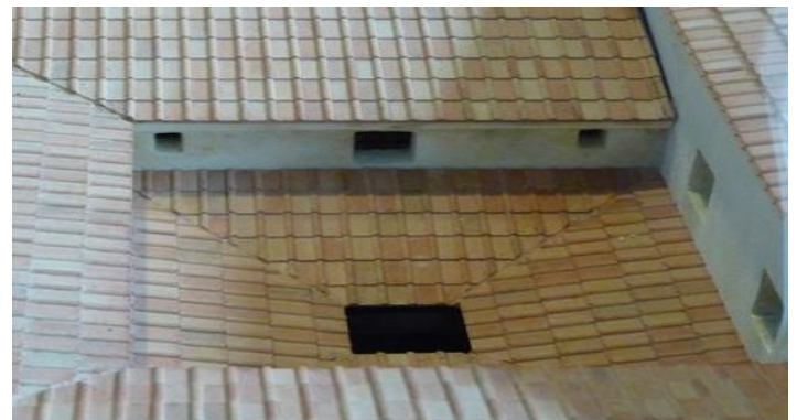
Un trou dans le toit au-dessus de l'atrium permet la récupération des eaux de pluie
